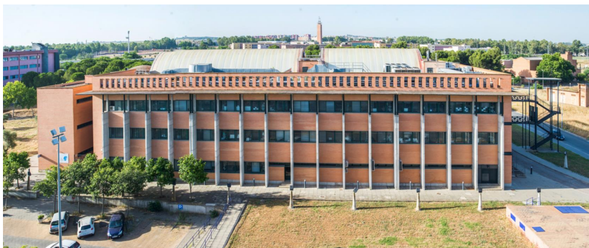
Edificio J.A. Campos Ortega, donde se ubica el CABD en Sevilla
